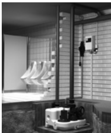
Рис. 108 Пример установки Multilift MDG в приямке в подвальном помещении здания
