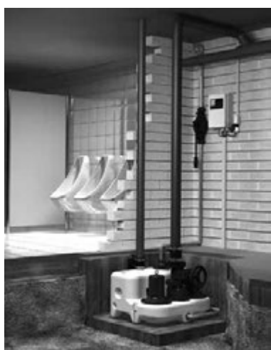
Рис. 89. Пример установки Multilift MOG в приямке в подвальном помещении здания
